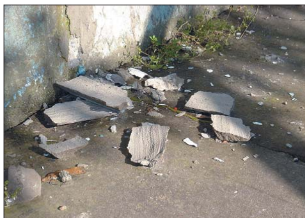
Рис.7. Панельные дома в г. Слюдянка. Внизу — осыпание растворной заделки межпанельных швов — 1-я степень повреждения по шкале MSK-64 (слева) и повреждение горизонтального шва между стеновыми панелями лестничной клетки — 2-я степень повреждения.
