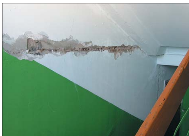
Рис.7. Панельные дома в г. Слюдянка. Внизу — осыпание растворной заделки межпанельных швов — 1-я степень повреждения по шкале MSK-64 (слева) и повреждение горизонтального шва между стеновыми панелями лестничной клетки — 2-я степень повреждения.
